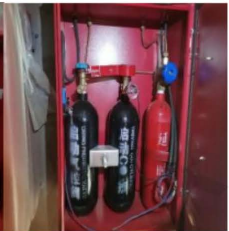
图3.4.8 气瓶及管路施放阀
