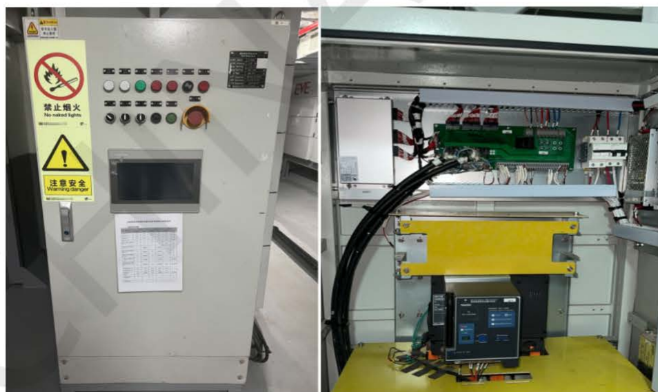
图 1.1.3 电池管理系统控制柜
