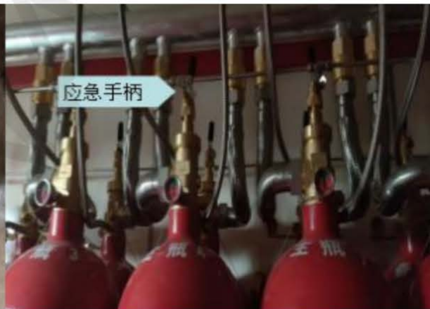
图 3.4.10 主气瓶上的应急手柄
