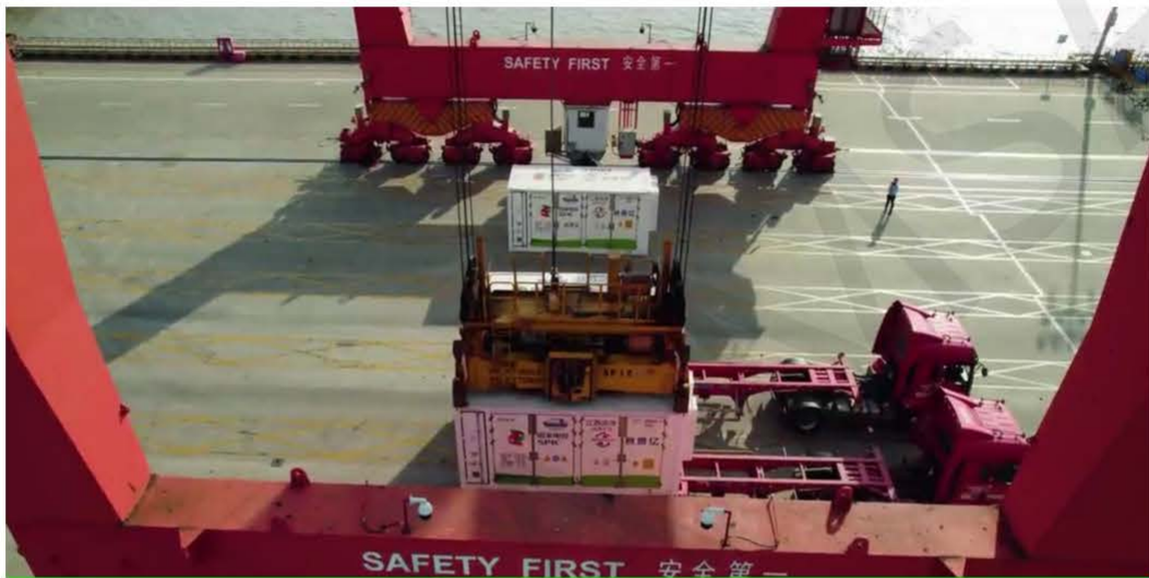
图 8.3.1 箱式电源的吊装
